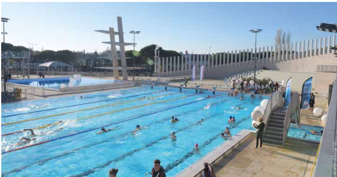
Le bassin olympique, désormais ouvert toute l'année, dispose d'une couverture thermique motorisée afin de maîtriser les déperditions thermiques.
